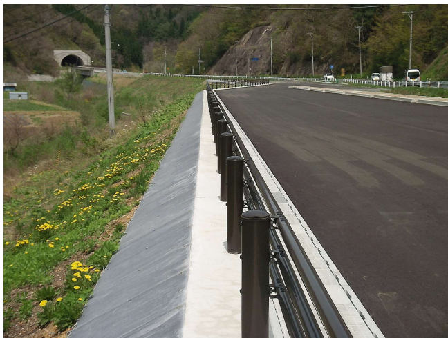
防草板・梁川ダム付け替え106号.JPG
