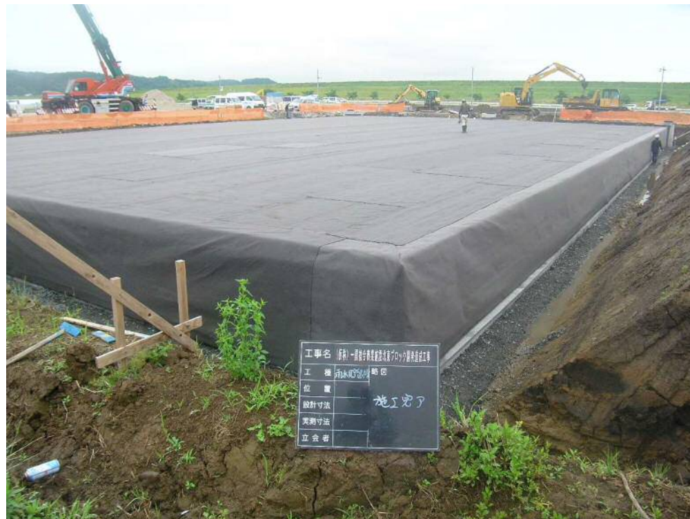
クロスウェーブ・一関商業施設・施工③.JPG
