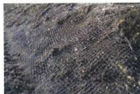
植生基材吹付工
