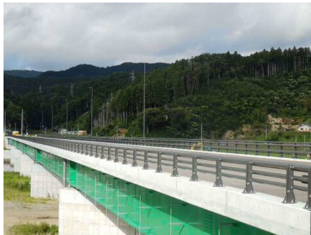
高欄・今泉大橋②.JPG
