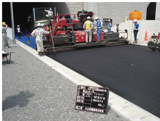
北山トンネル入口2.舗装.JPG
