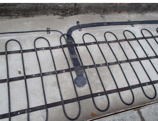
盛岡停車場線1.ヒーター敷設.JPG
