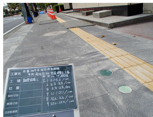
盛岡停車場線3.歩道板設置.JPG
