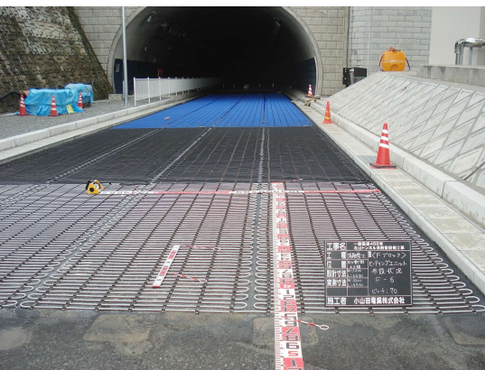
北山トンネル入口1.ヒーター敷設.JPG
