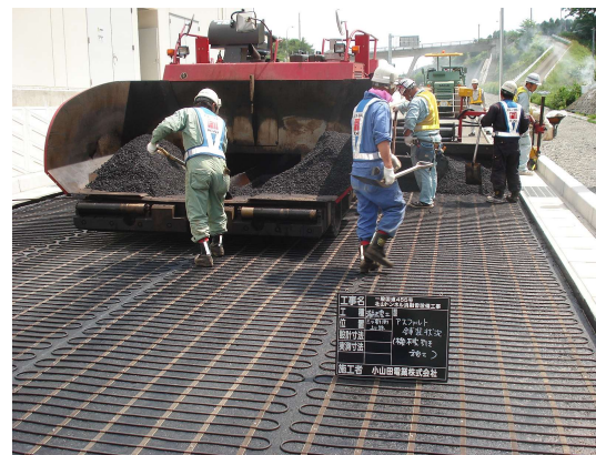
北山トンネル出口3.ヒーター敷設.JPG
