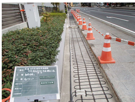
盛岡停車場線2.ヒーターユニット結合.JPG
