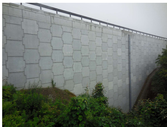
テールアルメ・三陸自動車道.JPG
