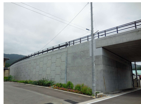
テールアルメ・陸前高田市高田米崎道路.JPG
