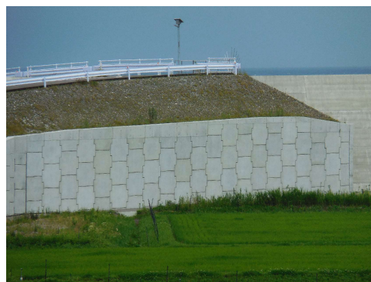
テールアルメ・陸前高田市・只出漁港①.JPG
